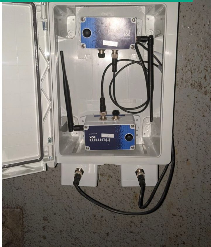
Hummbox en sous-sol alimentés en batterie
