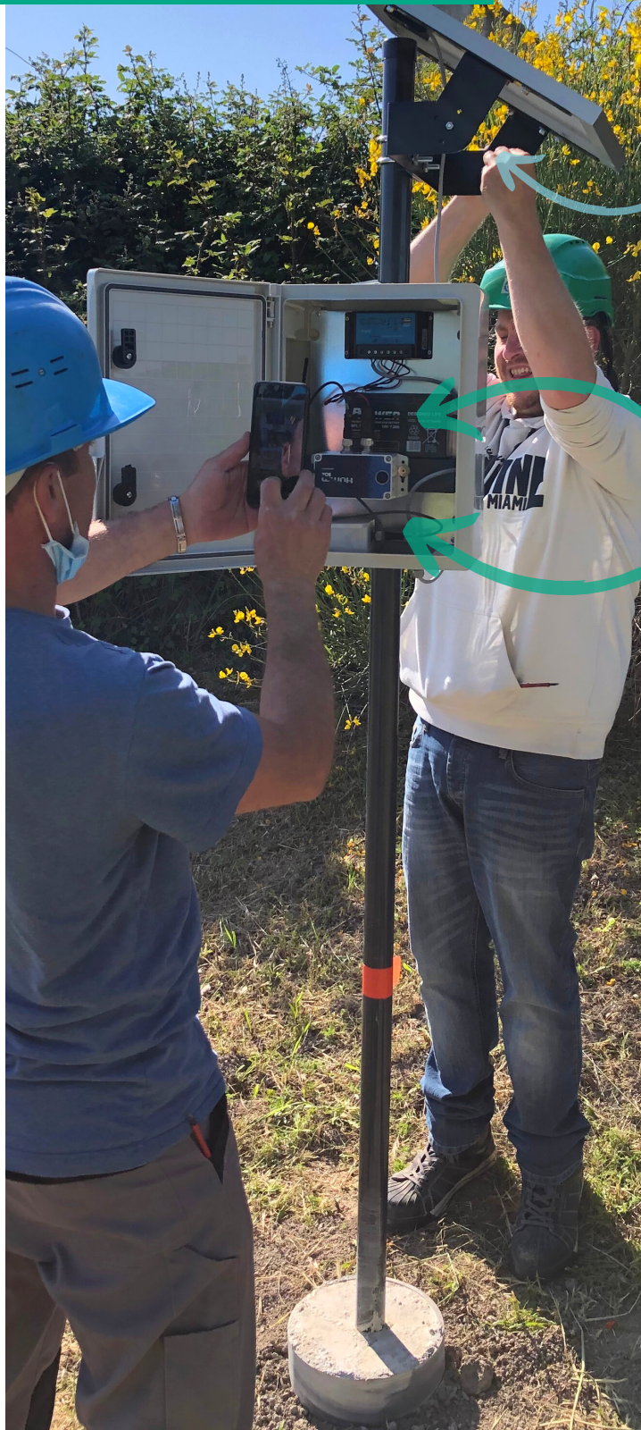
Hummbox extérieurs alimentés en solaire
