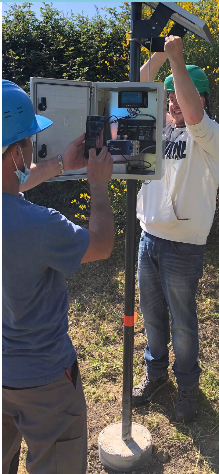
Montage sur mât fixé au sol
